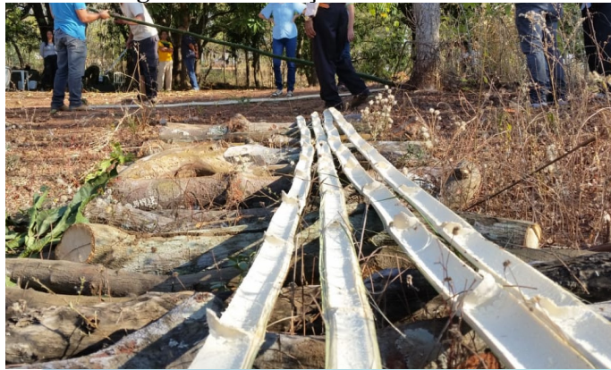
Figura 4: Construção da base da leira
