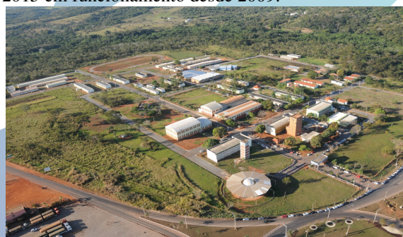
Figura 6 - Atual Câmpus II em Barra do Garças-MT, 2015 em funcionamento desde 2009.
