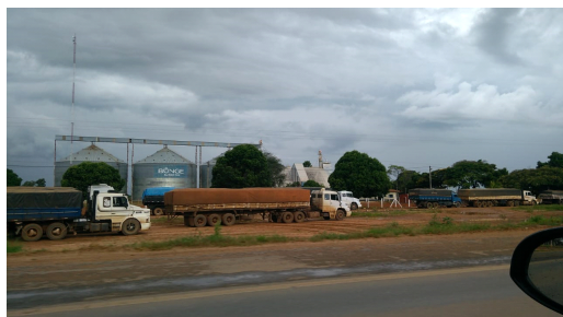
Figura 1 – Silo Metálico convencional e Silo Bag no Oeste Baiano.
