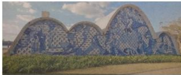
Figura 1 – Igreja São Francisco de Assis, Belo horizonte, 2011. Fonte: DANTE, 2013, p.71.
