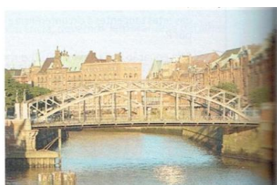
Ponte em Hamburgo, Alemanha.
