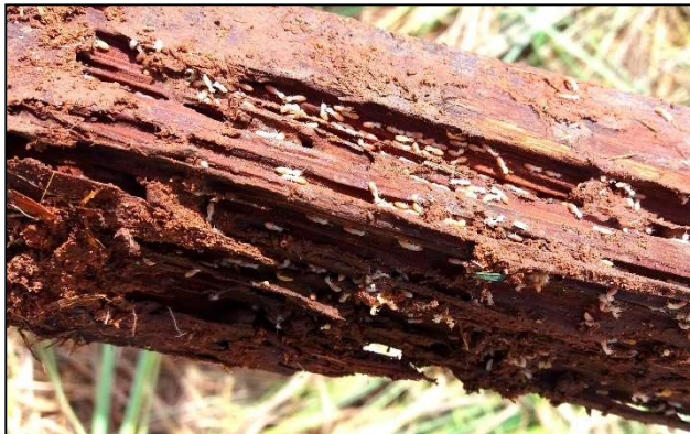
Figura 2. Aspecto de corpo de prova com elevado grau de deterioração causado por Heterotermes tenuis . Figure 2. Aspect of a specimen with a high degree of deterioration caused by Heterotermes tenuis .
