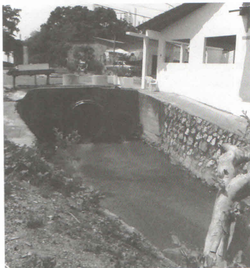
Figura 11: Construção numa margem do Córrego, eliminação da área permanente em outra e substituição do leito por manilhas a montante. Foto: Alexandre da Silva (Nov./2008)
