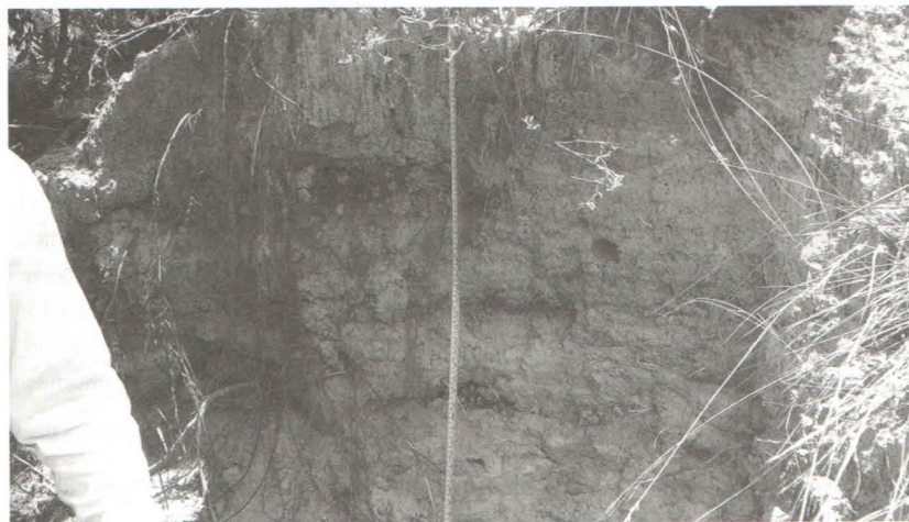
Figura 8: Perfil de solo, que se encontra exposto no interior da voçoroca, onde realizou-se coleta de amostragem no ponto 2 do flanco direito da Vereda do Sono.
