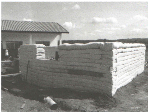
Figura 05 – Travamento das paredes.
