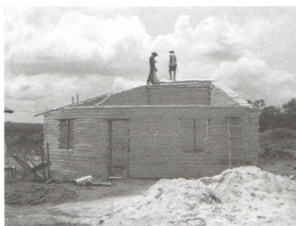
Figura 12 – Últimas fiadas das paredes. Foto: Julia Martinaitis Gonçalves
