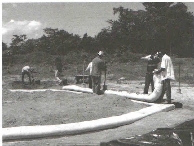
Figura 04 – Início da construção com Superadobe. Foto: Julia Martinaitis Gonçalves
