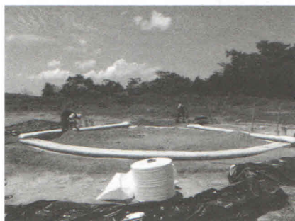
Figura 06 – Construção da sala com superadobe.
