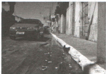
Figura 5: Esgoto correndo a céu aberto – Itaituba/PA Foto: Luiz Gonzaga Toledo, 2006
