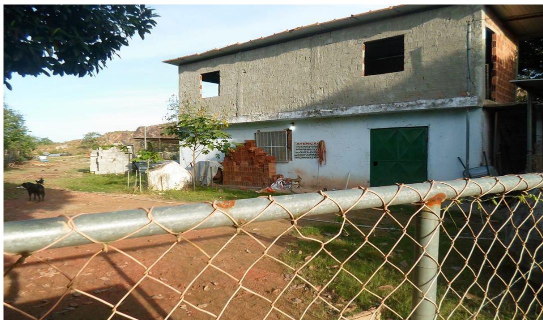
Figura 6 - Única fonte de água potável do bairro.
