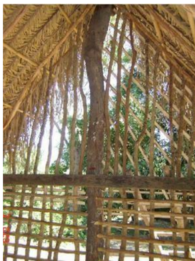
Figura 6: Sistema de tramas de uma casa pantaneira. Fonte: Galdino e Silva, 2009.
