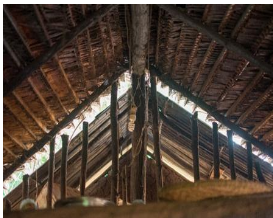
Figura 4: Cobertura da casa quilombola. Fonte: Autor (2017).
