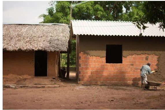
Figura 3: Casa de alvenaria convencional sendo edificada ao lado da habitação vernácula. Fonte: Autor, 2017.
