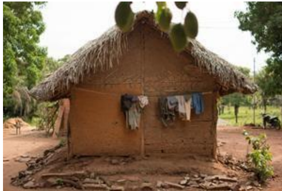
Figura 2: Casa de taipa de mão parcialmente revestida. Fonte: Autor, 2017.
