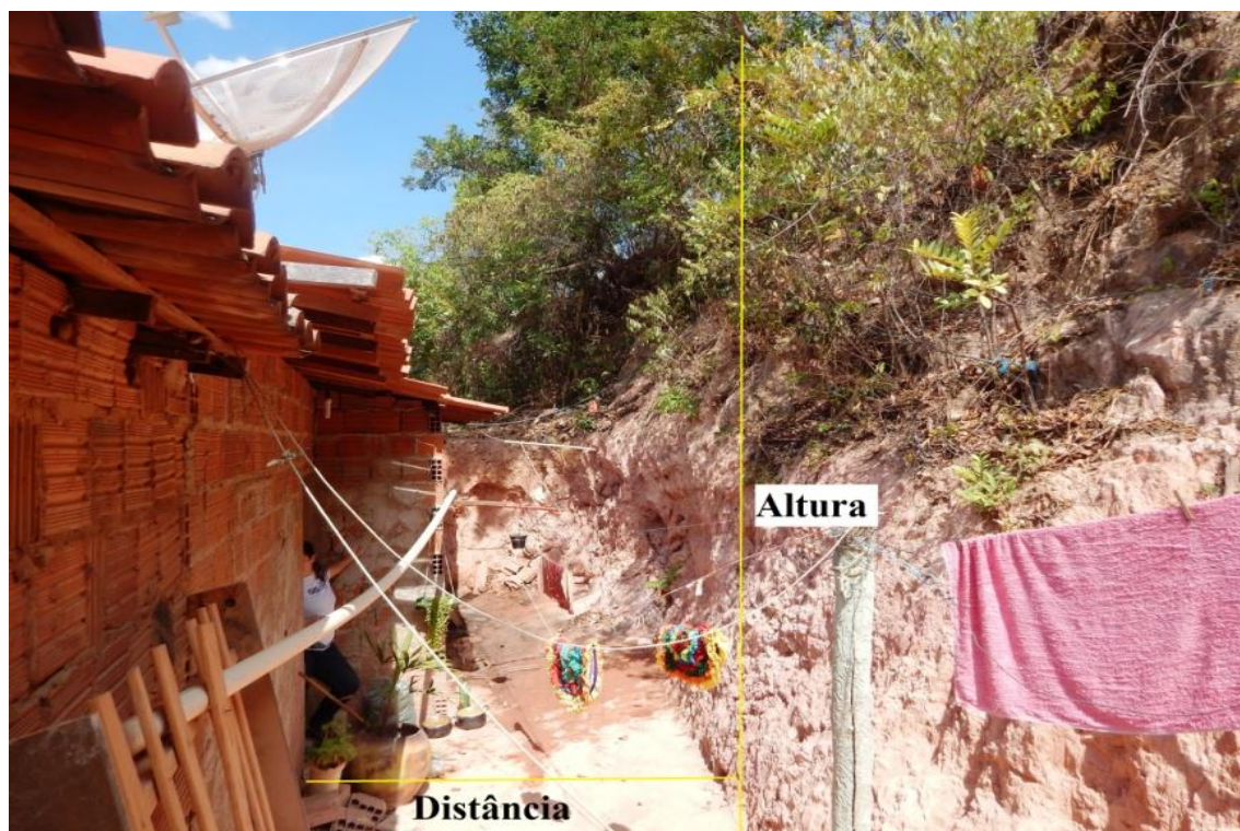
Figura 3 - Ocupação muito próxima do talude sob risco de atingimento Fonte: Silva (2017)
