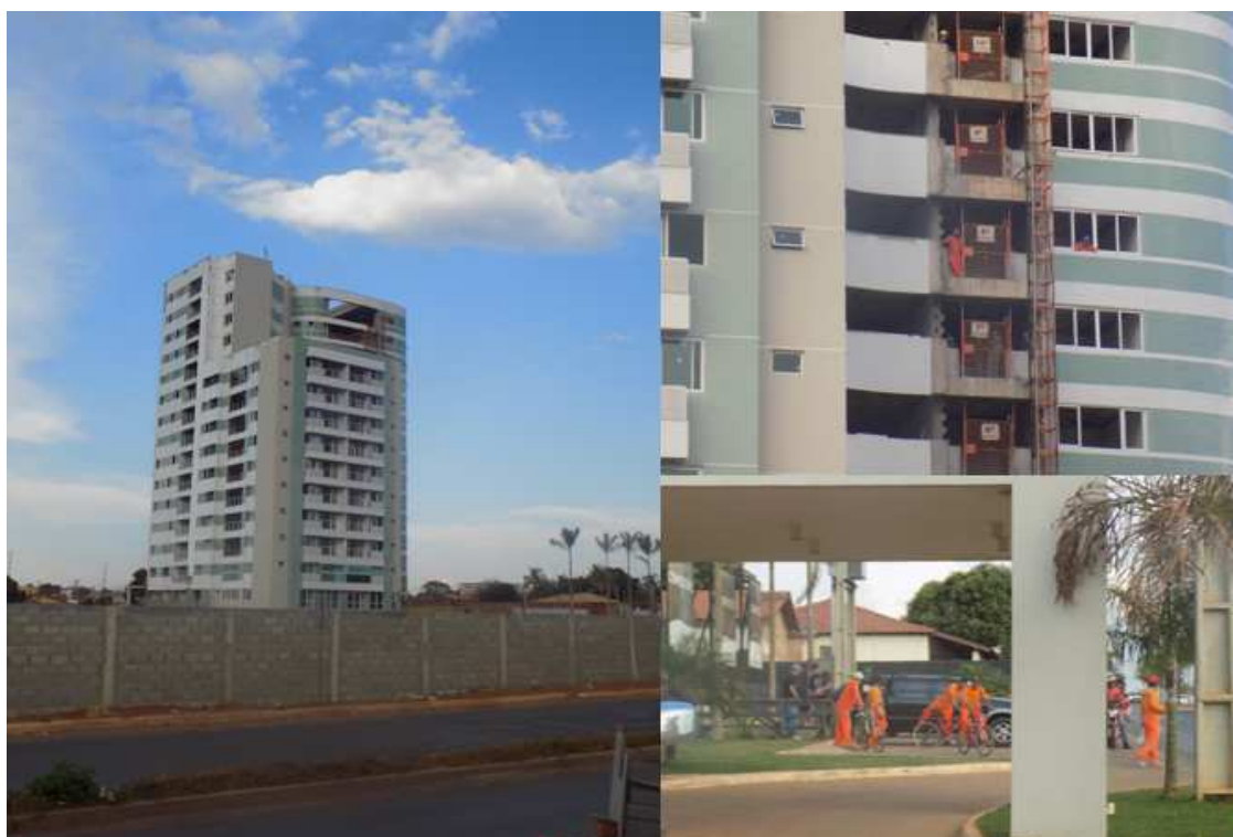
Figura 02: Construção de prédio no Setor Sul em Formosa, um dos bairros mais valorizados da cidade em 2015.
