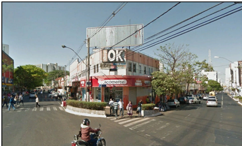
Foto 2 - Fachada do “Shop OK” em Uberlândia (MG)
