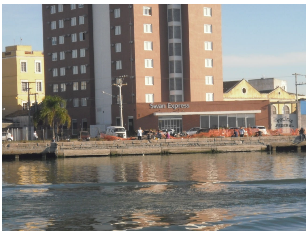
Figura I: hotel construído a margem da obra em processo revitalização.
