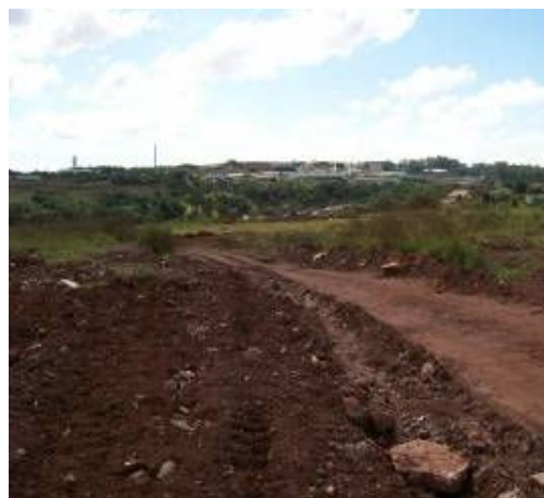
Figura 10: Vista de parte da área da Localização 2, próximo ao curso do Córrego Liso. Autor: Oliveira (2009).
