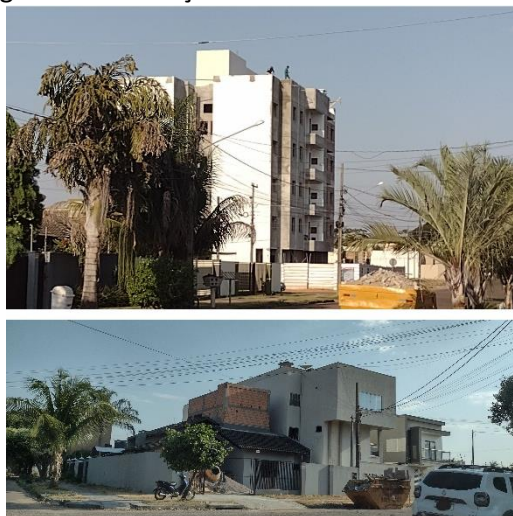
Figura 6. Construções residenciais verticalizadas
