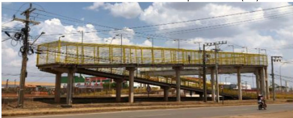
Figura 2- Passarela localizada na área urbana do município de Sorriso (MT) sobre a BR-163
