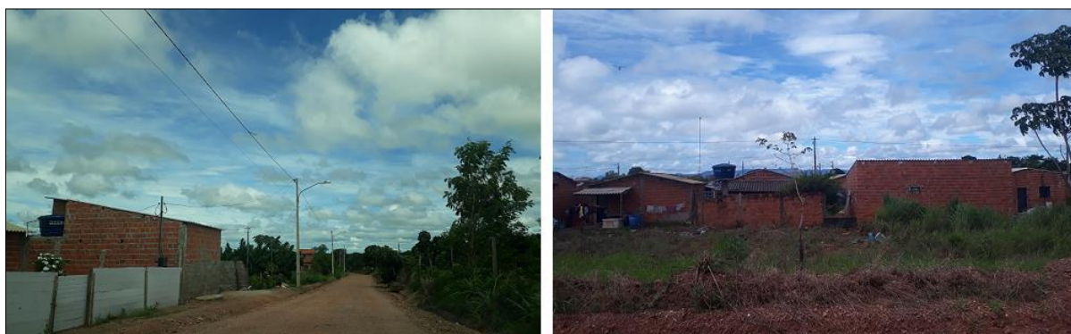
Figura 7. Setor 2 – Loteamento Nova Vitória Fonte: Autores (2018).
