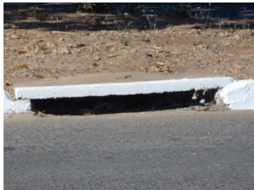
Figura 17 - Bocas de lobo em boas condições no bairro Santa Marta
