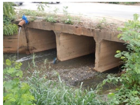
Figura 24 - Ponto 9 - Bueiro triplo
