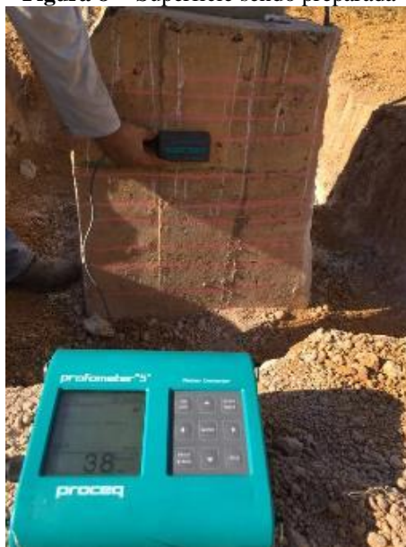
Figura 8 - Superfície sendo preparada
