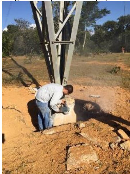
Figura 7 - Superfície sendo preparada
