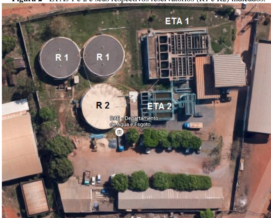
Figura 2 - ETAs 1 e 2 e seus respectivos reservatórios (R1 e R2) indicados.
