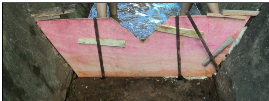
Figura 3 - Posicionamento das estacas de ferro e dos tocos de madeira
