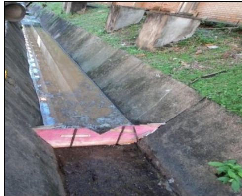
Figura 4 - (b) Estanqueidade da água devido adição da argila.
