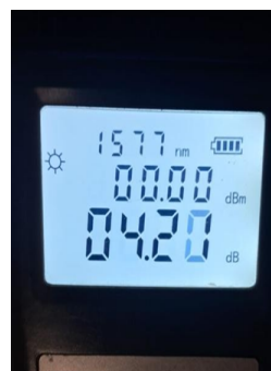
Figura 8 – Medição da potência óptica na saída da OLT XGS-PON.
