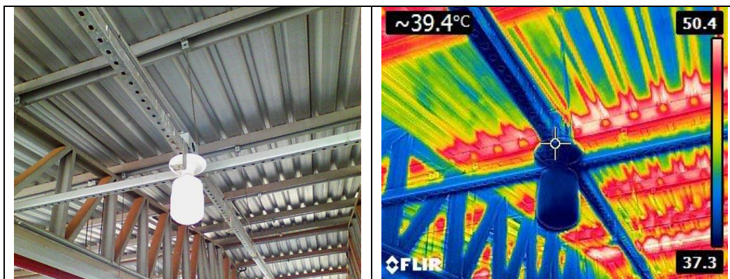
Figura 15 – Vista inferior da cobertura
