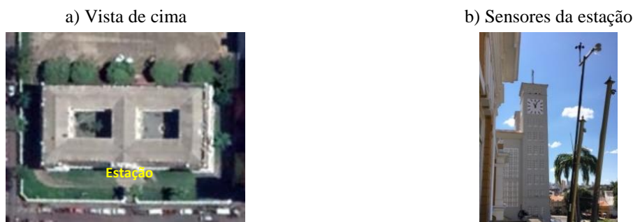
Figura 2 – Estação meteorológica instalada na cobertura do edifício Palácio da Instrução
