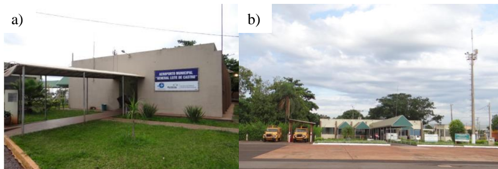
Figura 11 - a) Terminal de passageiros e b) Terminal de passageiros (lado ar) do Aeroporto de Rio Verde
