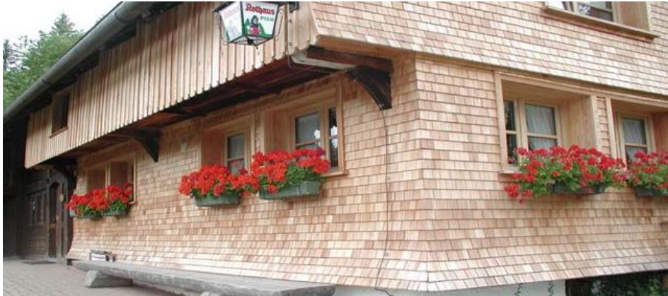
Figura 5 - Edifício composto por ladrilhos de madeira.
