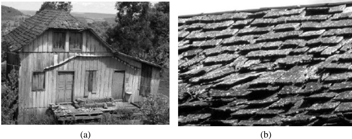
Figura 3 - (a) Habitação com cobertura de taubilha e (b) Telha do tipo taubilha.
