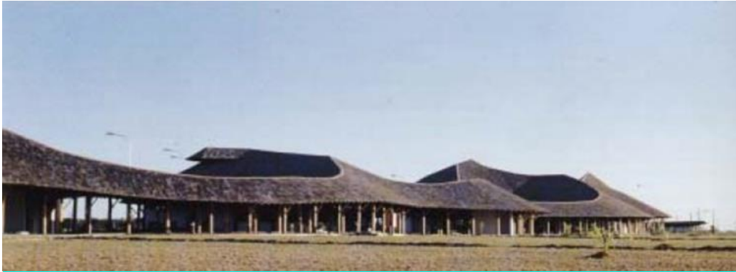
Figura 1 - Centro de Proteção Ambiental de Balbina. Detalhamento da cobertura com tabuinhas.
