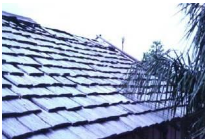
Figura 2 - Habitação com telha de madeira em Aripuanã (MT), sobreposição das telhas de madeira.
