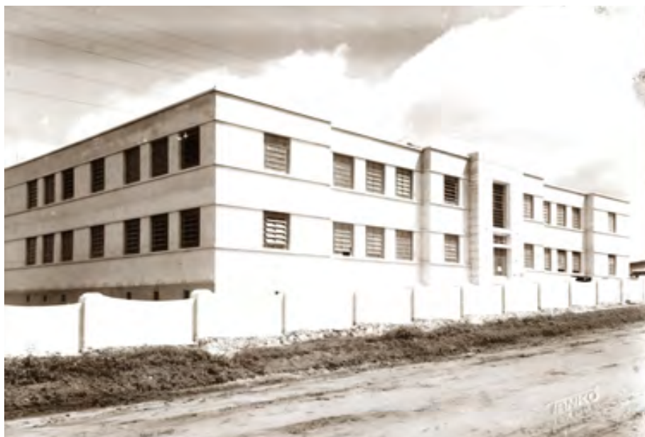
Imagem 1- Prédio do Ginásio Estadual de Santo Antônio da Platina, 1953
