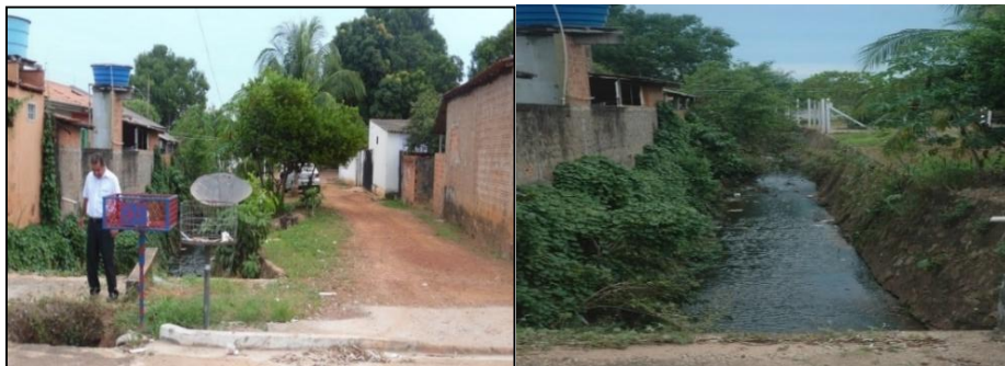
FIGURAS 13 e 14- Córrego Patrimônio – Loteamento Alves, presença de construções desrespeitando a distância mínima de 10 metros da canalização, esgoto sendo jogado diretamente no Córrego através de encanamentos das moradias, lixo. Construções depositando esgoto diretamente no Córrego Patrimônio. Foto: A.A.P., Maio/2016
