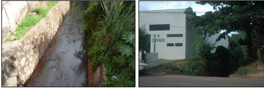
FIGURAS 11 e 12- Córrego Patrimônio – Região Central – Observamos a canalização aberta, à aproximadamente 100 metros da nascente do curso d’água a existência de um prédio da SEMED, Secretaria Municipal de Educação, a uma distância bem inferior aos 10 metros. Foto: A. A. P., Maio/2016.
