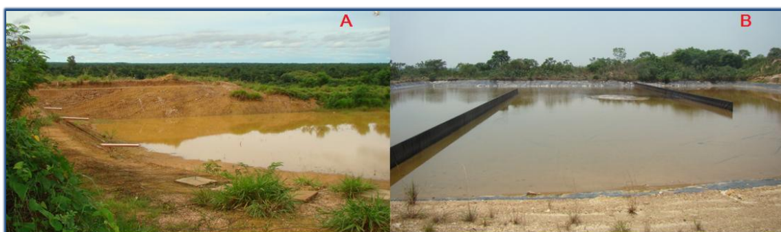
Figura 14A e 14B – Lagoas de Estabilização para tratamento de efluentes antes e após o revestimento no bairro Morro da Boa Vista em Nossa Senhora do Livramento-MT (Fonte: Acervo dos autores)
