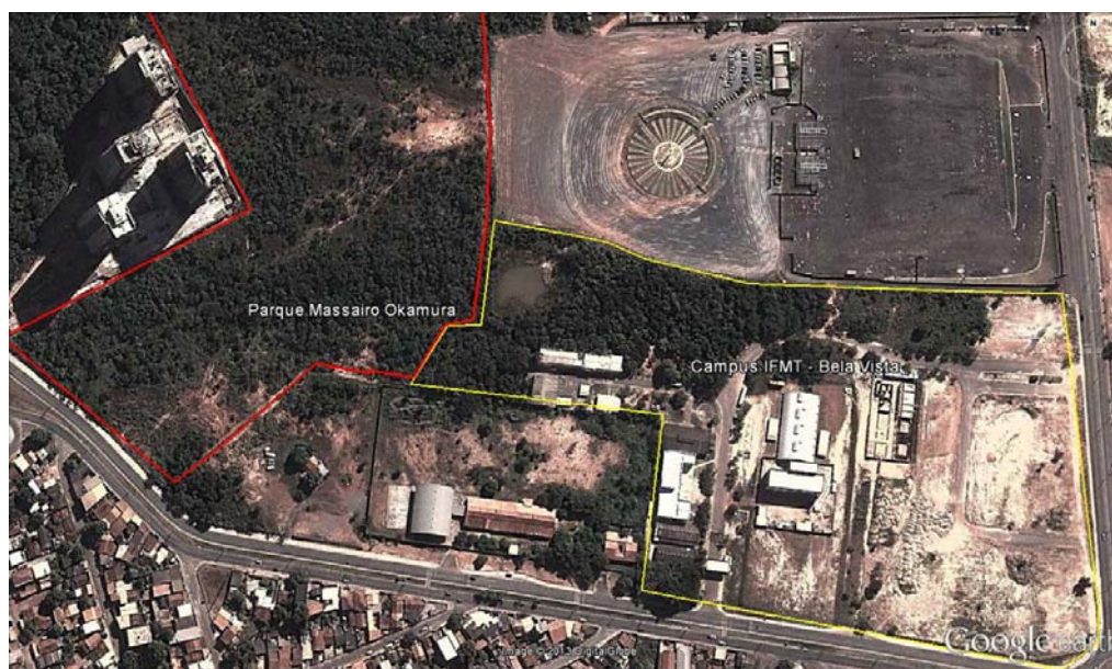
FIGURA 1: Imagem parcial de satélite da vegetação do Parque Massairo Okamura, em destaque o IFMT Campus Bela Vista. Fonte: Google Earth, 2013
