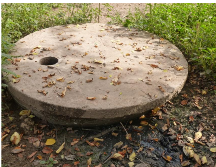
FIGURA 6. Fossa rudimentar contaminando o solo I (Fonte: Registros feitos durante as entrevistas na comunidade).
