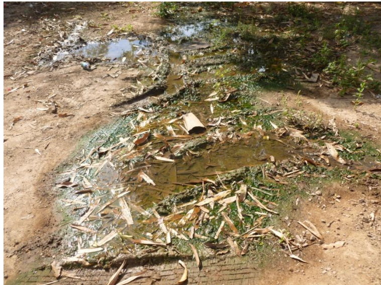
FIGURA 7. Esgoto transbordando de uma fossa e contaminando o solo (Registros feitos durante as entrevistas na comunidade).
