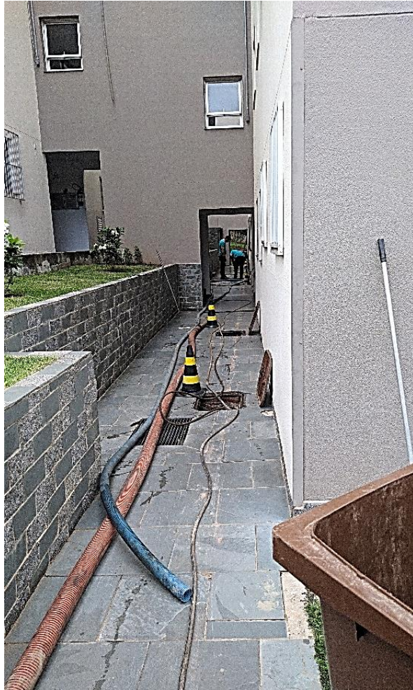
Figura 2. Abertura das caixas de gordura e passagem das mangueiras de desobstrução.
