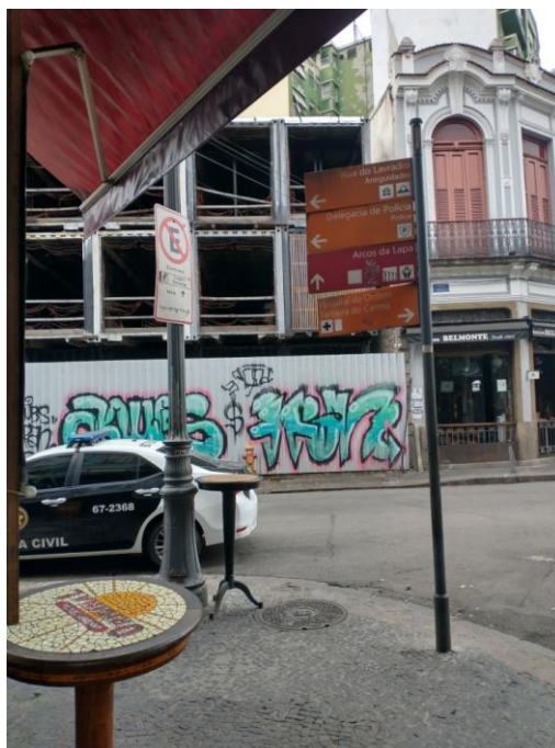
Figura 3 – Cruzamento da Avenida Mem de Sá com a Rua do Lavradio.
