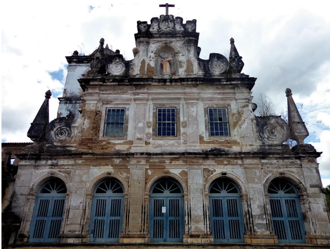
Foto 10 – Cada pedra calcária assentada com óleo de baleia pela mão de obra escravizada ergueu o Convento de Santo Antônio do Paraguaçu na comunidade em 1654.
