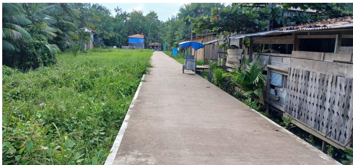
Foto 1 – Ponte de concreto na várzea. Do autor, 2025.
