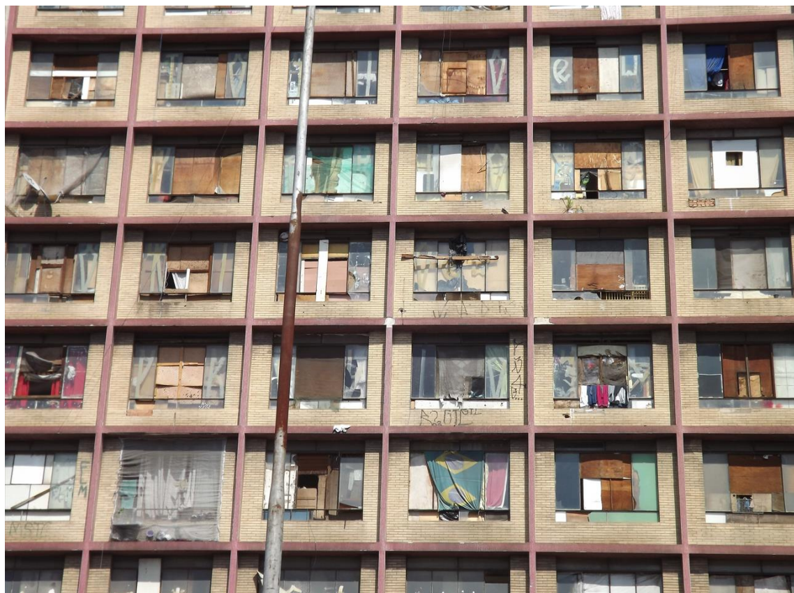
Foto 2 – Fachada do edifício Prestes Maia, voltada para avenida homônima. Os subsequentes proprietários do imóvel, durante décadas, não cumpriram sua função social. Esse abandono gerou uma sequência de ocupações realizadas por movimentos sociais, muitas vezes seguidas por reintegrações de posse emitidas pelo Poder Judiciário em favor do proprietário. No entanto, restituída a posse e desocupado o imóvel, prosseguia o desrespeito à legislação brasileira e a permanência do imóvel vazio. Nesses casos, o valor de troca se sobrepõe ao valor de uso e a especulação imobiliária se impõe sobre o direito à moradia. As marcas da ociosidade e da deterioração são visíveis na foto pois, como se vê, quase nenhuma janela se mantém íntegra e funciona. O fechamento improvisado com tapumes e panos foi realizado por pessoas que ocupavam a edificação de forma improvisada à época. Por trás de cada janela há uma família pobre desassistida por políticas públicas, em situação de vulnerabilidade social, com carências materiais básicas, sem condições de comprar ou alugar um imóvel. O Prestes Maia foi desapropriado pela prefeitura de São Paulo, com a promessa de reabilitar a edificação e convertê-la em habitação de interesse social (19 outubro 2016).
