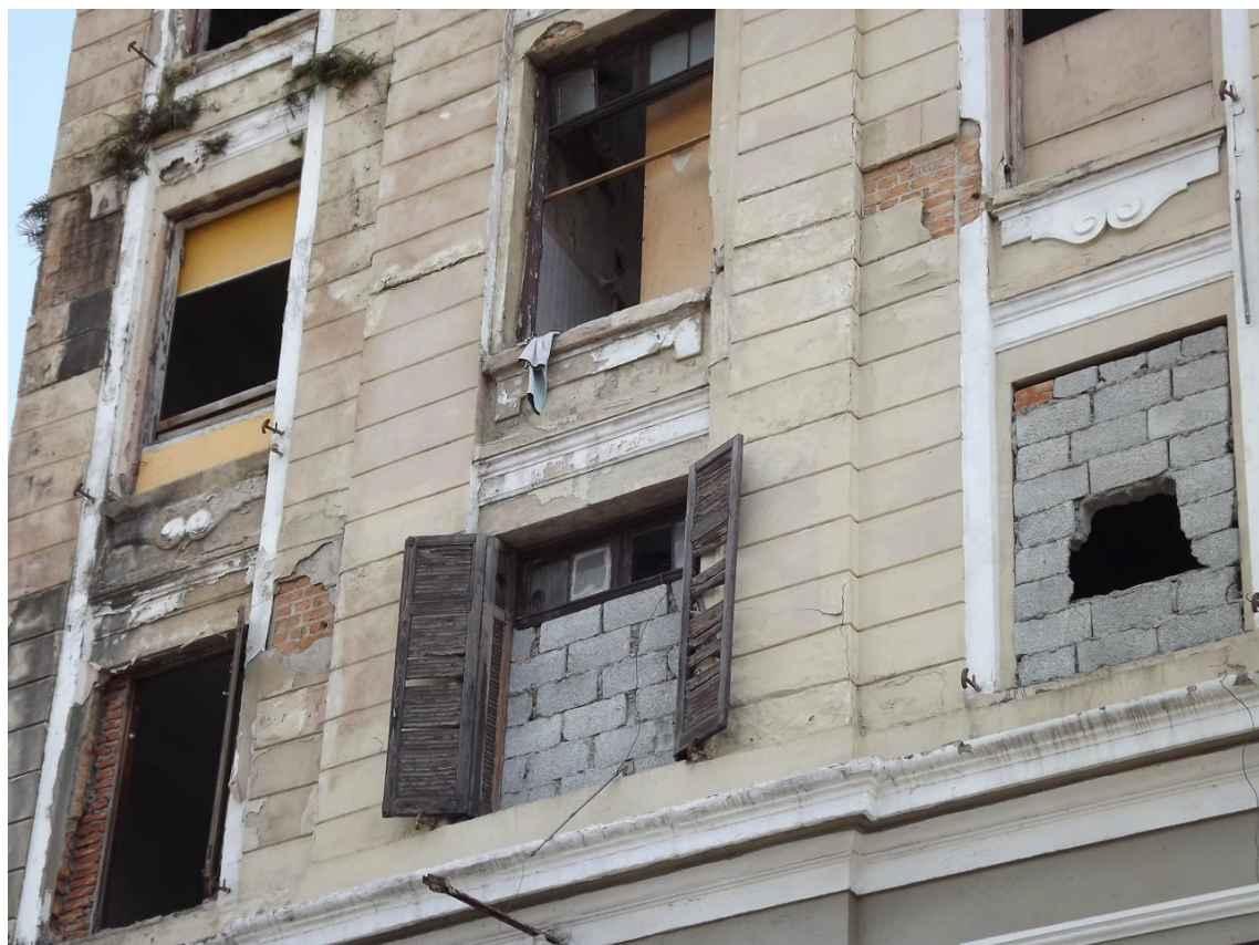
Foto 4 – Edifício localizado na rua General Couto de Magalhães n. 381, Santa Ifigênia, imóvel tombado pelo Conselho de Defesa do Patrimônio Histórico, Arqueológico, Artístico e Turístico do Estado de São Paulo (CONDEPHAAT). Antítese das janelas da foto anterior, aqui, várias delas foram fechadas com paredes de alvenaria, inutilizando a abertura e o antigo caixilho de madeira. No edifício Prestes Maia, mesmo com risco iminente de despejo, os ocupantes restituem como podem as fachadas e, com isso, contribuem para manter a integridade física da edificação. Aqui, a construção de um muro com blocos de concreto sobre o vazio das janelas é uma prova de que o proprietário não tem intenção de ocupá-lo. O resultado é uma anti-janela e o completo fechamento do prédio, que se torna um monumento morto. A região em que se encontra o imóvel, entre a rua Mauá e a avenida Rio Branco, tem uma concentração grande de moradores de rua com problema de dependência química, a chamada "cracolândia". A área também sofre intervenções pontuais do mercado imobiliário, em certos casos com participação do Poder Público, como o famigerado projeto Nova Luz. Imóveis abandonados como esse de certo não ajudam a democratizar acesso e permanência de populações vulneráveis e transeuntes à moradia adequada (5 agosto 2015).
